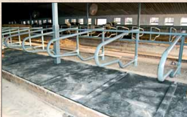
V maštaliach pre dojnice montovali v čase našej návštevy do ležiskových boxov gumené matrace.
