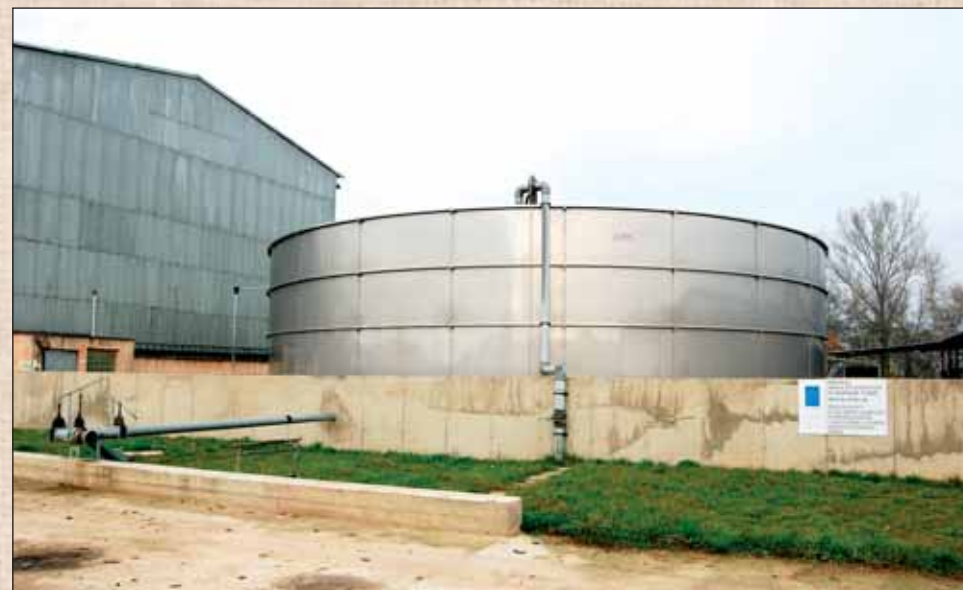
Nádrž na tekutý odpad z farmy má vybudovaný záchytný systém v prípade havárie.
